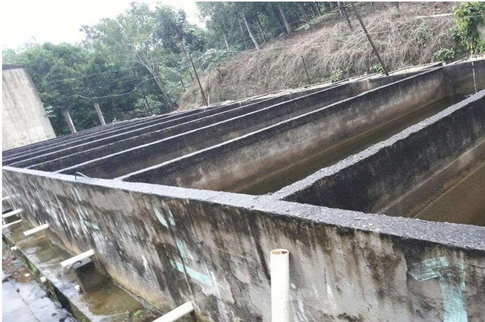
Imagen 7. Fosas de sedimentación para la utilización de la cerdasa como
